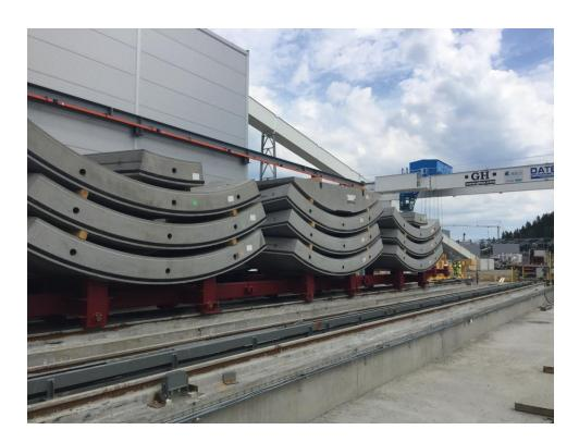
Sieben Betonsegmente werden benötigt, um einen kompletten Tunnelring zu montieren. Insgesamt werden für die Herstellung des 18,5 km langen Doppeltunnels fast 20.000 komplette Ringe oder 140.000 Betonsegmente benötigt.
